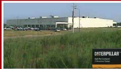
OXFORD PLANT (USA)
